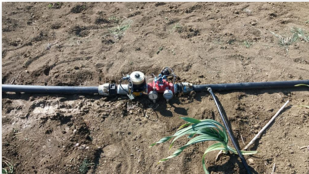
Figura 21: Contaltri e pressostato per il monitoraggio dei parametri di irrigazione
